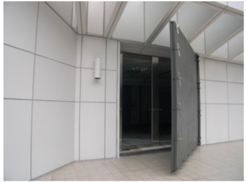
圖2 國家檔案典藏場所正門口防水閘門
